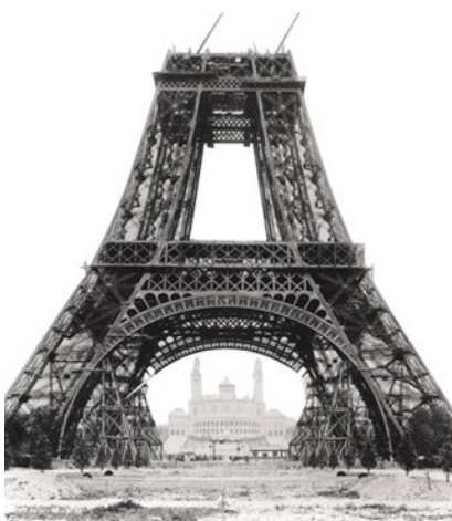
Si noti l'orientamento simile tra le strutture di base della torre e le trabecole del femore
