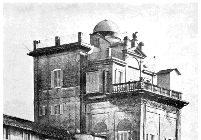
La Torre dei Venti, affacciata sui Giardini Vaticani, prima sede della Specola
